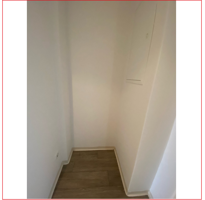
Ecke im Flur/Küchenbereich
